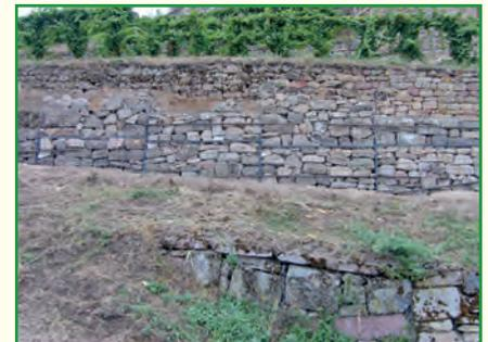
**2017:** Zisternenschacht bis Oberkante Gelände aufgemauert, Schießscharte erneuert, sowie Rep. am Mauerwerk
