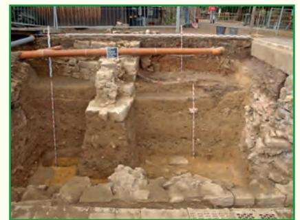
**2018-2020:** Sicherungsarbeiten bei den archäologischen Grabungen (Unterfangen der Mauern)
