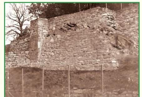
**1992 - 93:** Sanierung der Schildmauer. Spritzbeton von 1984 musste abgestemmt und untermauert werden.
