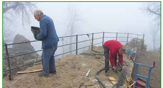
Schutzgeländer wurden in Eigenleistung hergestellt
