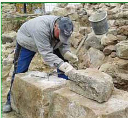
400 kg schwere Steine mussten versetzt werden
