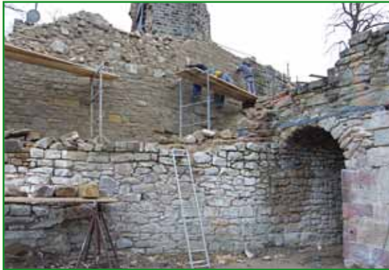
Arbeiten bei der Sanierung
