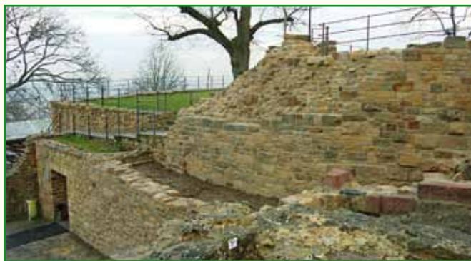
Sanierte Mauern vom Torhaus gesehen
