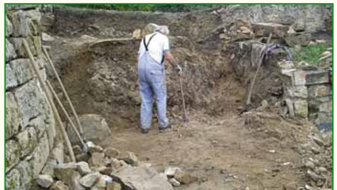
Freilegung des Torhauses in Eigenleistung
