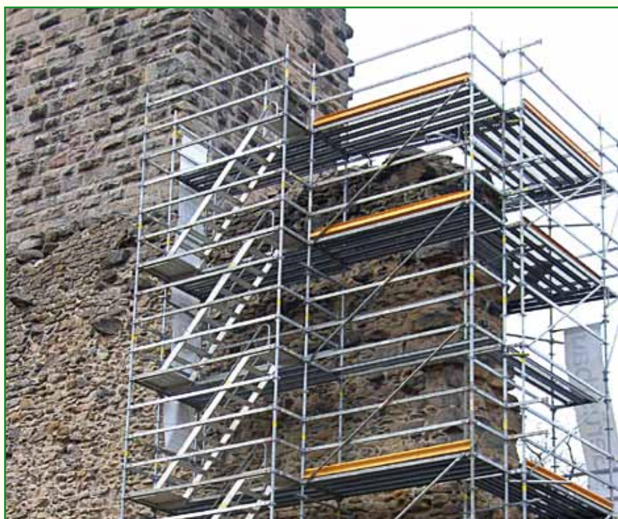
Gerüst an der Schildmauer
