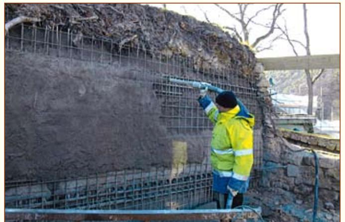
Der Beton wird mit hohem Druck zwischen die Bewehrungsseisen gespritzt.
