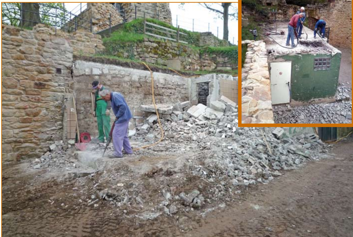
Im Bild: Herbert Heim und Berend Pauli bei Abbrucharbeiten
