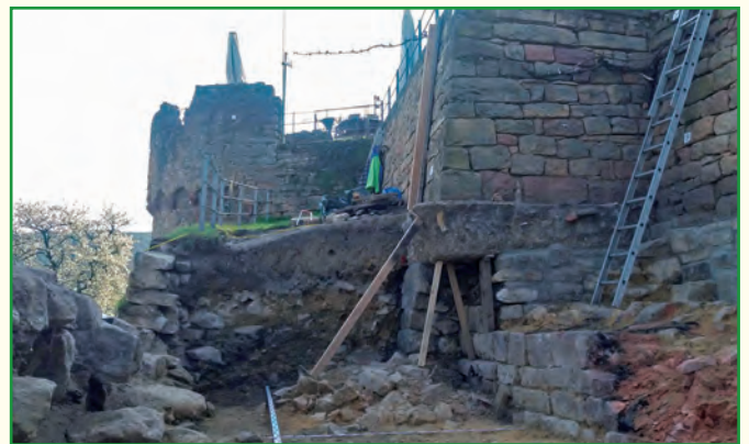
Freigelegtes Fundament vor der Gaststätte - Foto: Förderkreis
