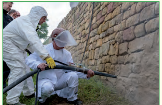
Peter Aschinger von der Firma Mader zeigt die richtige Entfernung zur Mauer. Foto: Guido Wollenberg
