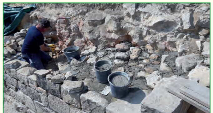
Loses Mauerwerk abtragen und neu aufmauern - Foto: Förderkreis
