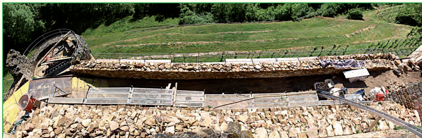
Abb. 1: Panoramablick auf die fast abgeschlossene Sanierung der östlichen Unterburg- sowie die Ringmauer mit noch stehenden Einrüstungen.
