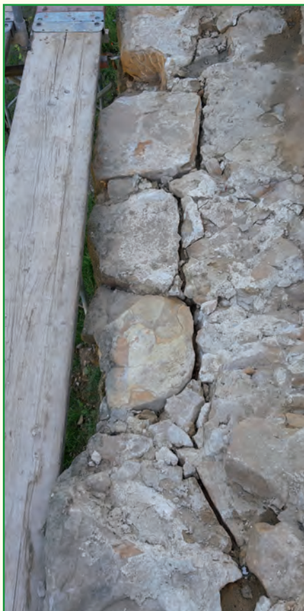
Abbildungen 2 und 3: Setzungsriss in der historischen Ringmauer und ein Blick auf die „Baustelle“ während der Sanierungsarbeiten.
