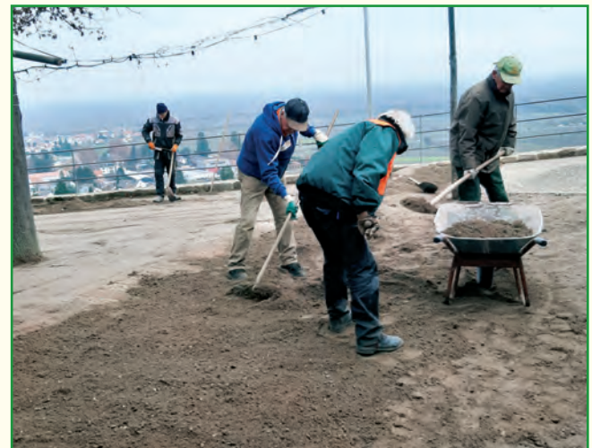
Planierarbeiten des Innenhofs
