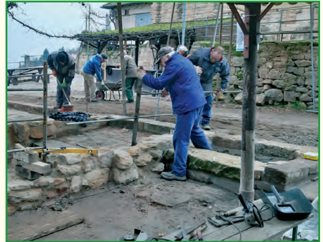
Erstellung des neuen Metallgeländers
