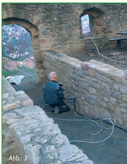
Verfugung der Wangenmauerung
