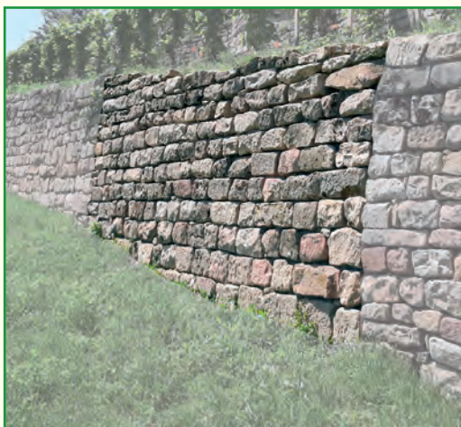
Die sanierte Mauer
