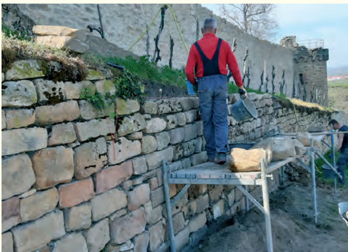
Die fast fertig sanierte Weinbergsmauer
