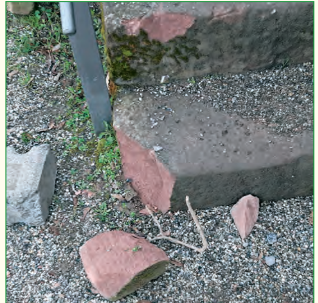
Zerstörte Sandsteinstufen
