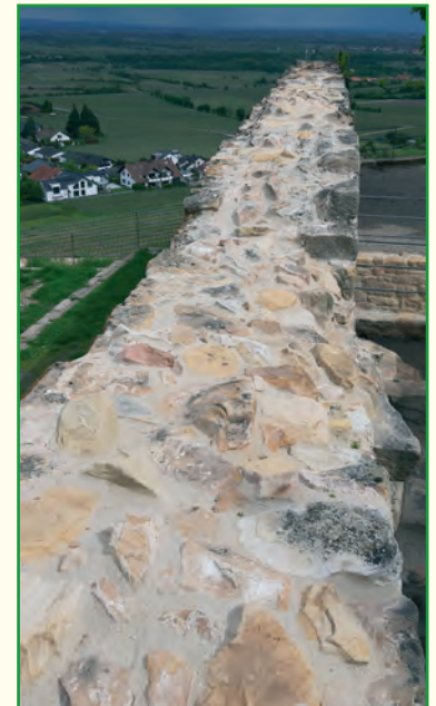
Sanierete Mauerkrone der Palaswand
