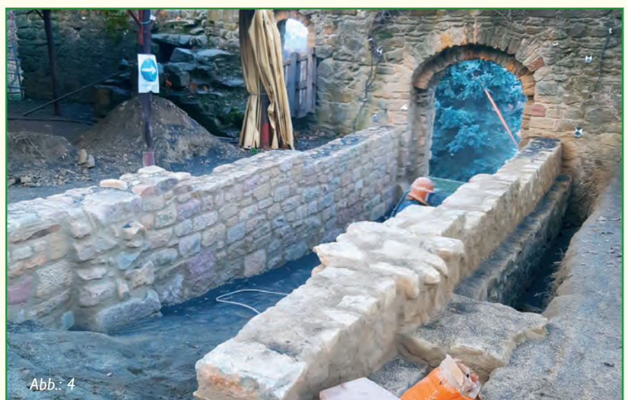
Abb. 1-4: Wiederherstellung der Wangenmauern zum Durchgang der Palaswand
