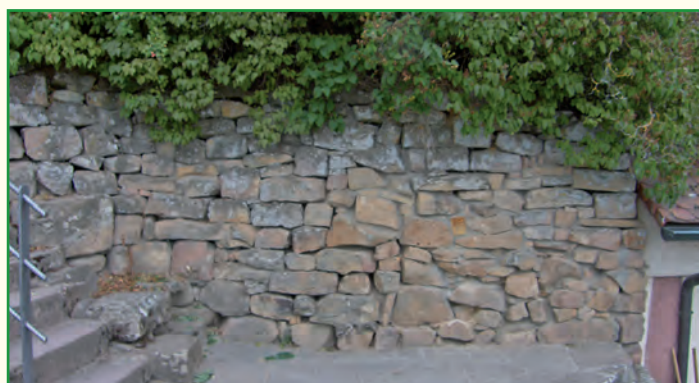
Die zu sanierende Mauer oberhalb der Burgschänke
