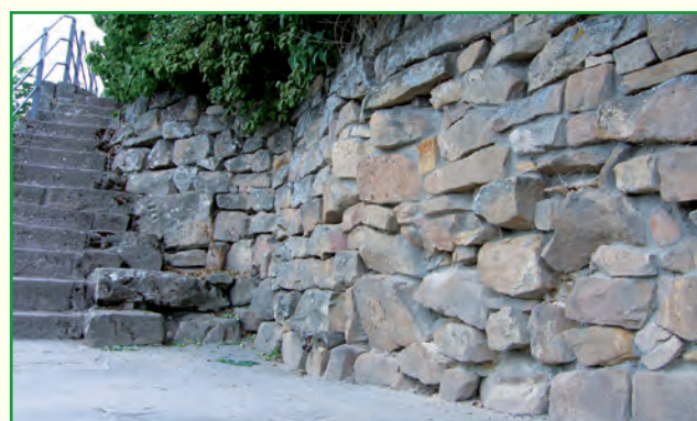
Die zu sanierende Mauer oberhalb der Burgschänke
