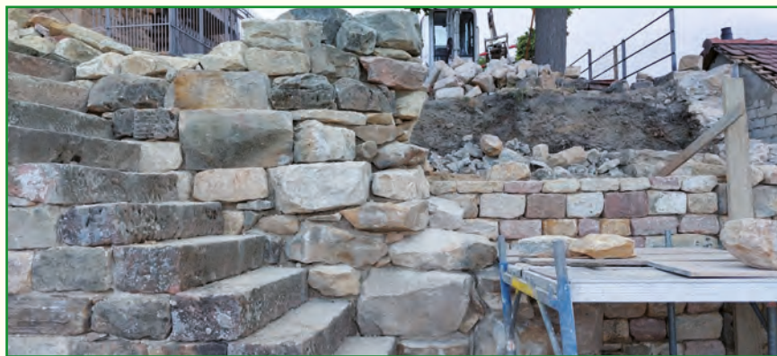
Hinter der Treppe die Mauer mit den großen Steinquadern
