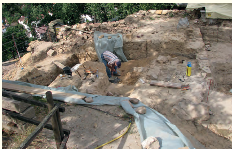
Abb. 1: Freilegungsarbeiten in der Kernburg der Wachtenburg mit Planierungshorizont der Bauernkriegszeit zwischen den Baubefunden (Foto: H. Kretzschmann).
