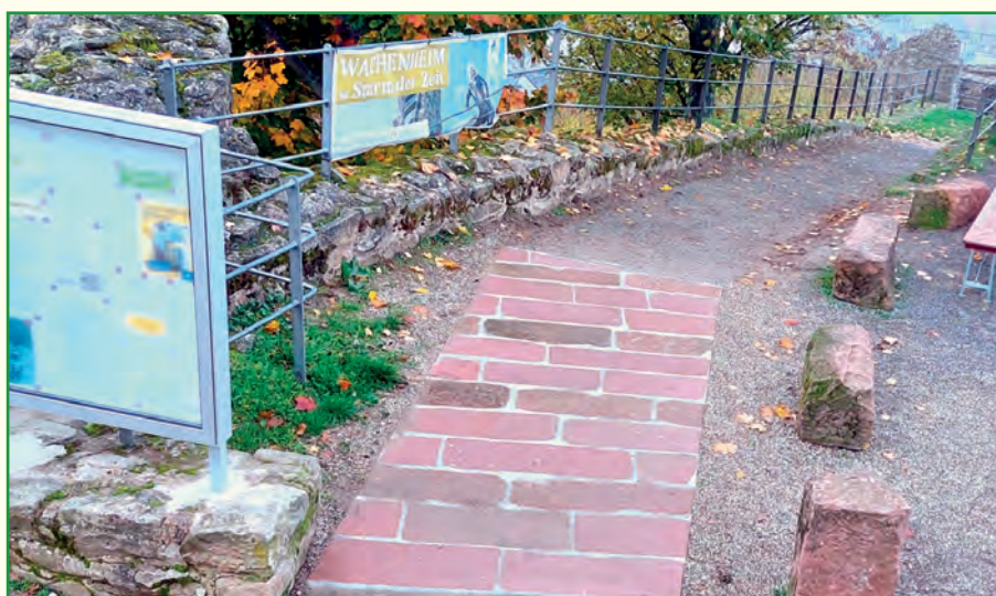
Foto 3: Im Bereich des Schaukastens mit Sandsteinplatten befestigt
