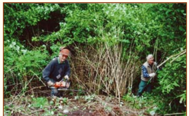
Freilegung auf beiden Seiten der Mauer von Bewuchs
