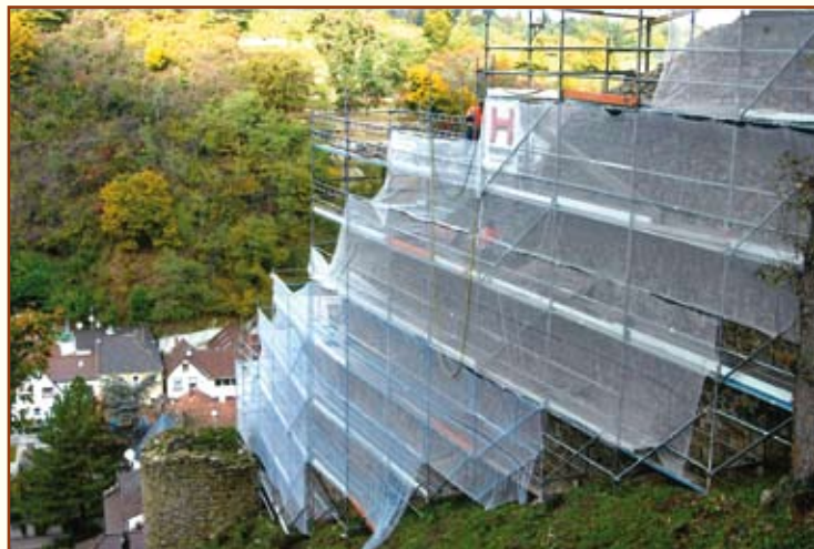
Eingerüstete Vorburgmauer West 2010 mit Blick auf die Schloßgasse
