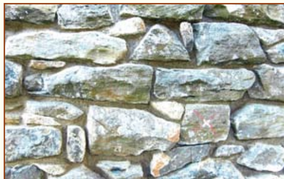
Bild unten: Vorburgmauer West (2010). Der sanierte Bereich im oberen Teil.
