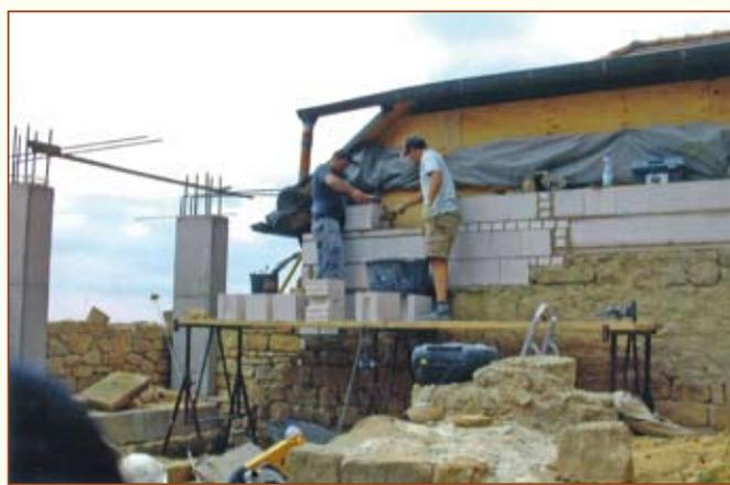
Auf dem historischen Mauerwerk wurde mit modernen und zeitgemäßen Materialien gearbeitet. Im Bild darunter: Auf der Nordoststrecke wurde das Verblendungsmauerwerk aus Sandstein montiert.
