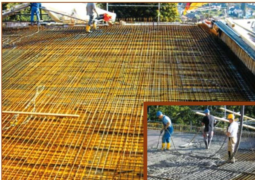
In die fertig bewehrte Stahlbetondecke wurden 26 Tonnen Stahl eingebaut und zum Betonieren der Stahlbetondecke wurden 105 Kubikmeter Beton verwendet. Siehe eingeblendetes Bild.
