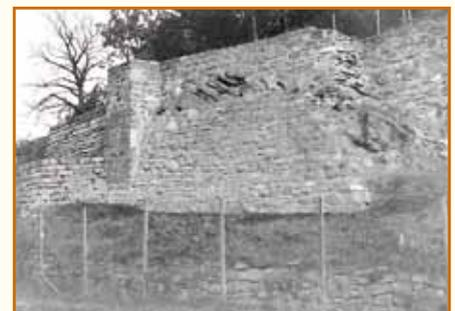
**1992 - 93** Sanierung der Schildmauer. Spritzbeton von 1984 musste abgestemmt und untermauert werden.
