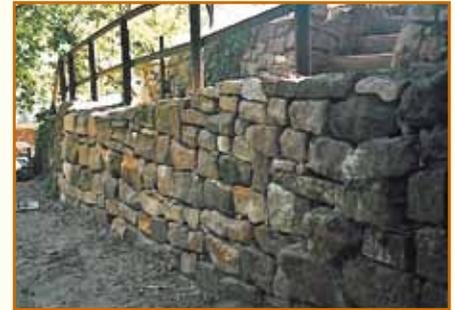
**1999 - 2000** Nordöstl. Ringmauer mit Sicherung des östl. Flankierungsturms und der davor liegenden Stützmauer.
