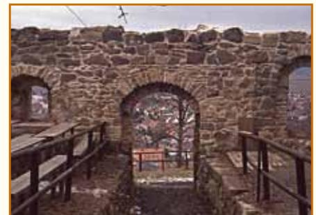
**1991** Sanierung des 2. Teils der Halsgrabenwand. Die Verwurzelung sprengte das Mauerwerk.
