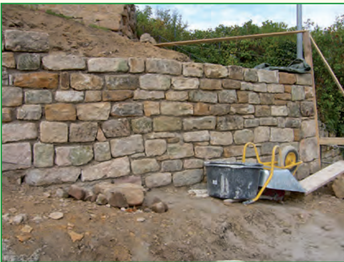
Die Stützmauer nimmt Form an
