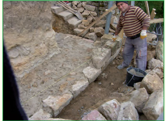
Das Aufmauern der Stützmauer
