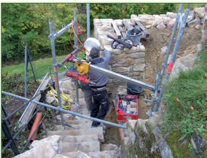
Vorbereitung der Bohrung zur Rückverankerung der Vorbürgmauer Süd-Ost
