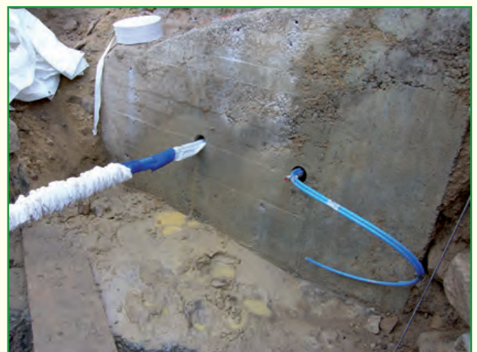
Einführung der Verankerungsseisen mit Strumpf (12 m - 14 m)
