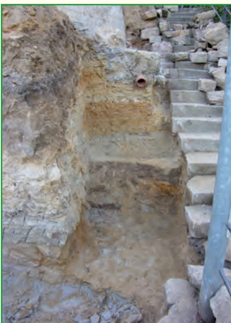
Das in den Fels abgestufte Gründungsfundament
