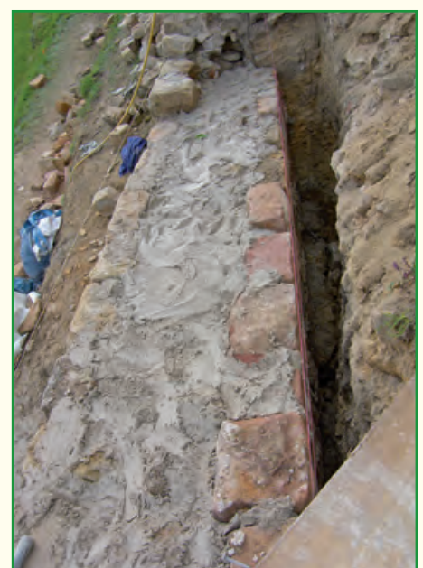
Das neue Stützmauerfundament aus Sandstein
