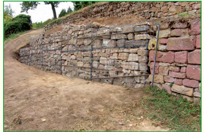
Die fertige Gabionenwand
