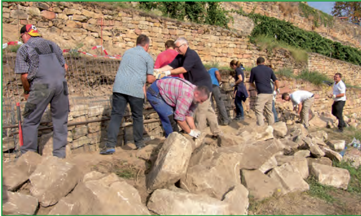
viele Hände beim Gabionenbau
