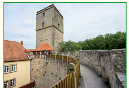
Wehrgang auf der Schildmauer zum Bergfried Foto frei
