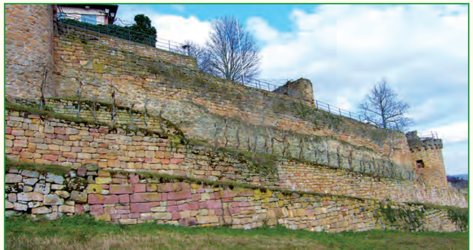
Die zu sanierende Ringmauer zwischen Ostturm und Turm der Gaststätte
