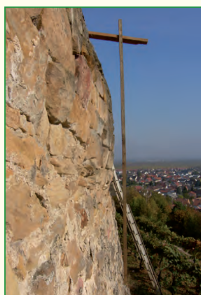
Risse in der historischen Mauer und Ausbauchungen bis zu 0,5 Meter
