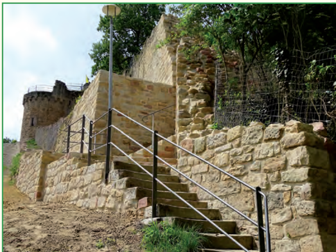
saniertes Teil im Bereich des Treppenaufganges
