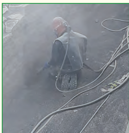
Reinigen des verfugten Mauerwerks
