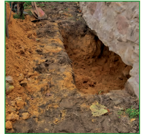
Fundament der Ringmauer zwischen Osturm und Turm der Gaststätte auf eine Länge von 2m freigelegt.
