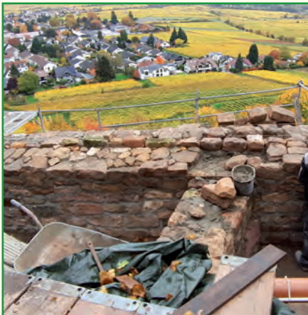
Die fast fertige Stützmauer vor dem Ausschank
