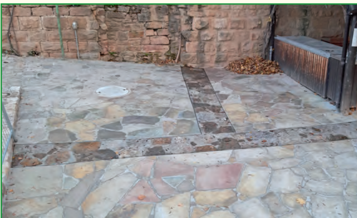
Fertiger Sandsteinbelag mit historischer Mauer aus dem 14. Jh.
