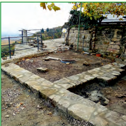
Hier sind die nur ca. 20 cm unter der Erdoberfläche angetroffenen Mauern aus dem 14. Jh. schon bis zur Geländeoberkante aufgemauert
