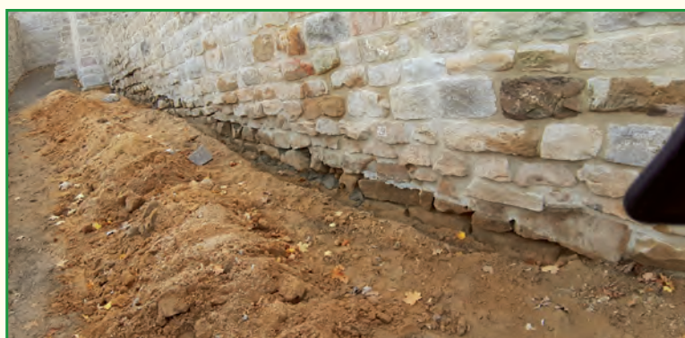
Foto 2: sehr schlechte Fundamente wurden von Hand freigegeben
