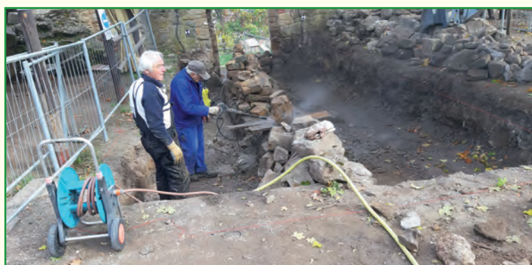
Foto 1: abgebaute Sandsteine reinigen und zum Lager im Halsgraben transportieren
