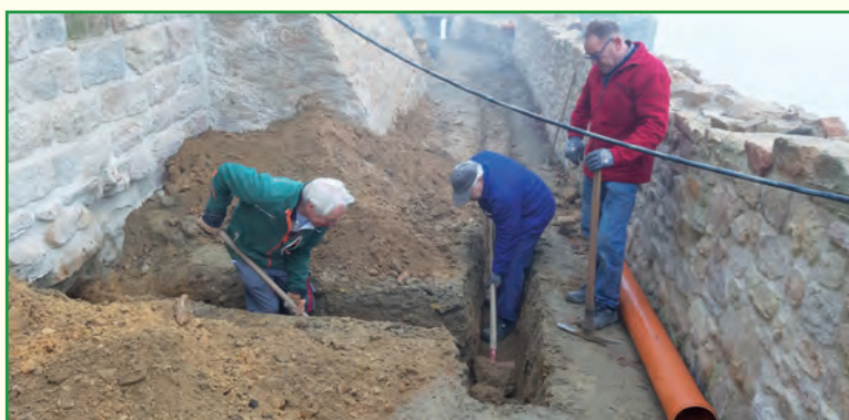
Foto 3: Aushub der Kanalgräben
