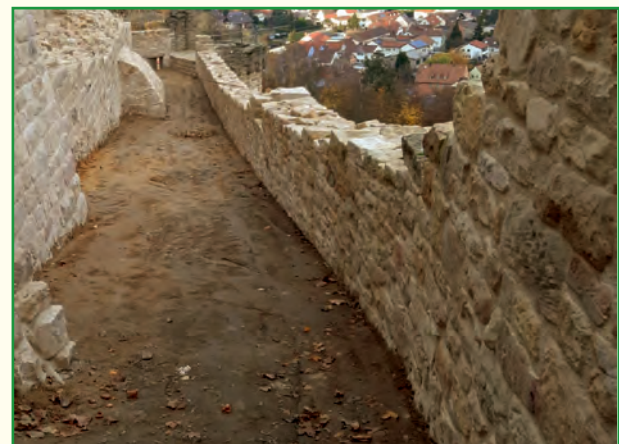
Blick in den sanierten Wehgang aus dem 14. Jh.
