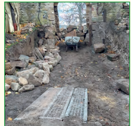
Die abgetragene Trockenmauer im Bereich des Zugangs zur Palaswand.
