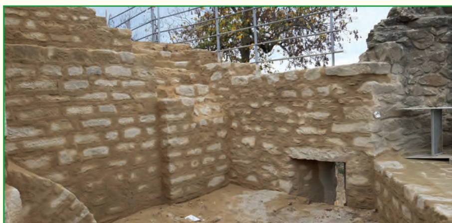
Das frisch verfugte Mauerwerk
