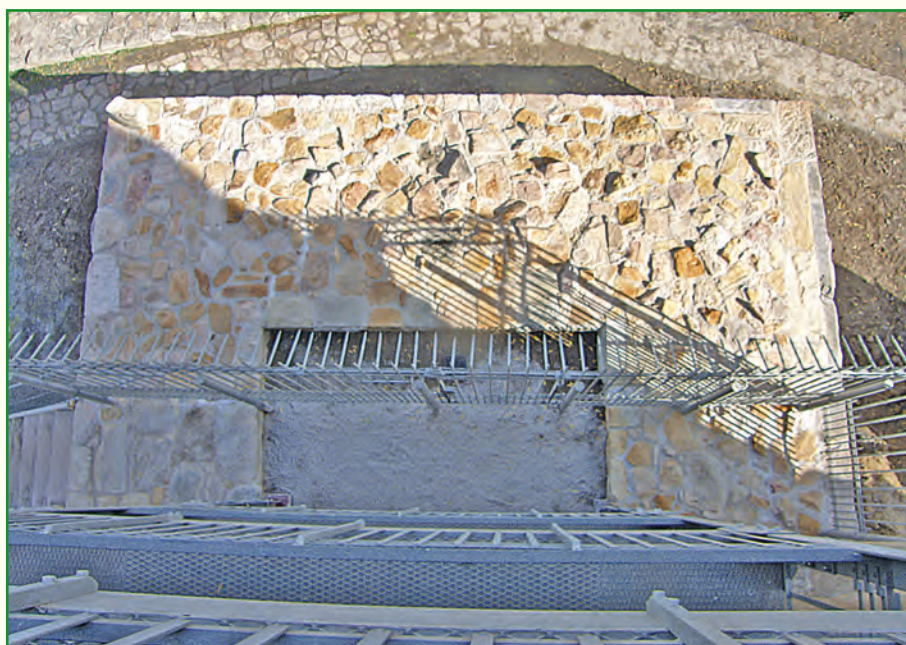
Draufsicht auf den fertiggestellten Fundamentsockel mit entstandenem Innenraum
