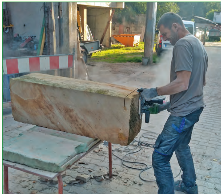
Zurichten der Fasslager zu Buckelquadern
