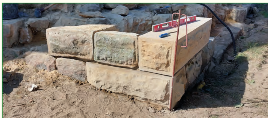
Mauerecke aus Buckelquadern
