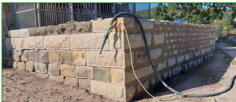
Fast fertig verfugter Fundamentsockel
