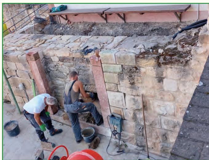
Versetzen der Gewände der ehemaligen Türöffnung
