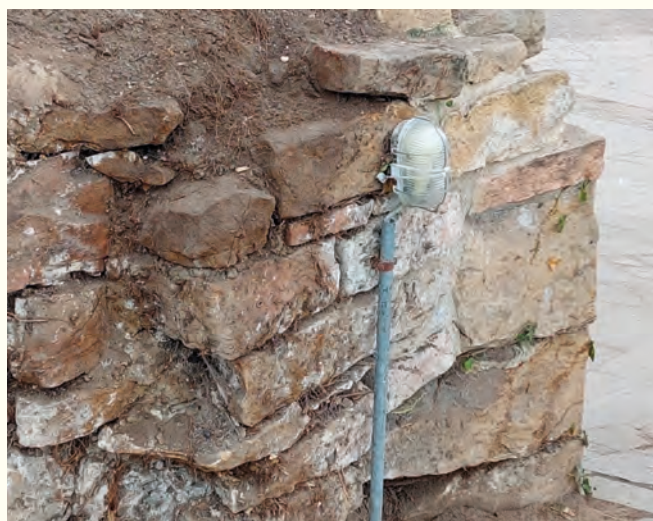
Historische Mauerecke vor der Gaststätte
