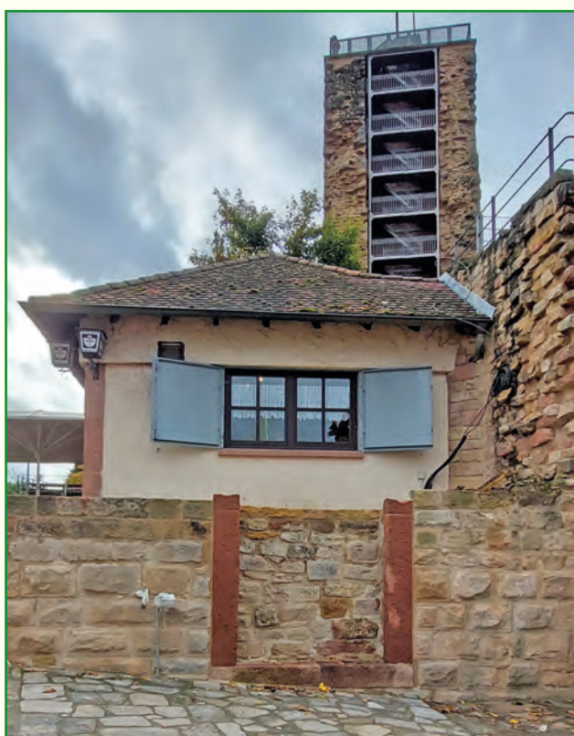
Sanierte Mauer vor der Burgschänke
