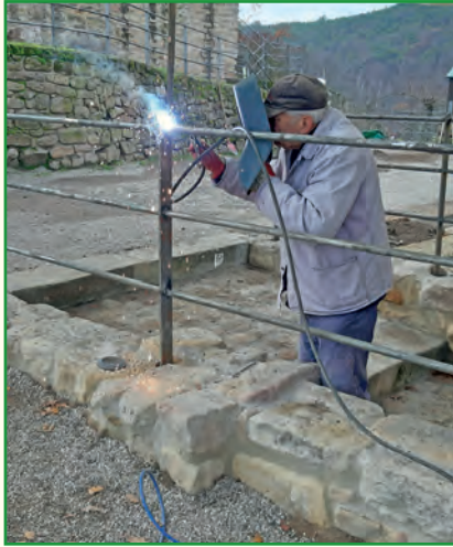
Herbert Heim bei Schweißarbeiten
