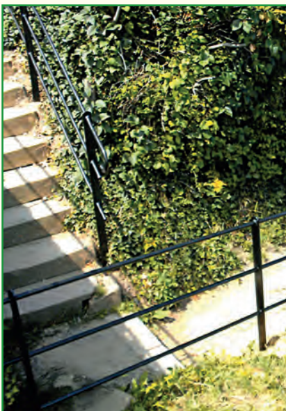
Fertiges Geländer am Treppenweg zur Burg
