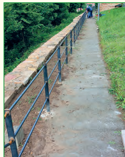
Das Geländer ist fertig geschweißt.
