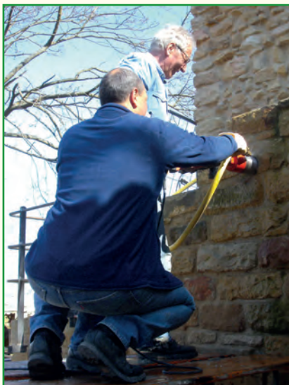
Herstellen von Kernbohrungen für ein Treppengeländer. Willy Bohl, Dieter Weilacher. Fotos: Förderkreis
