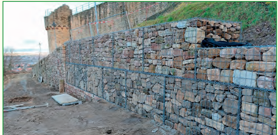
Insgesamt ist die neue Gabionenwand 32 Meter lang, 1 Meter stark und 2 Meter hoch. Foto: Förderkreis Wachtenburg
