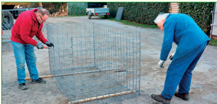
Foto 2. Zusammenbau der Gabionenkörbe. Karl-Heinz Herch, Herbert Heim. Foto: Förderkreis
